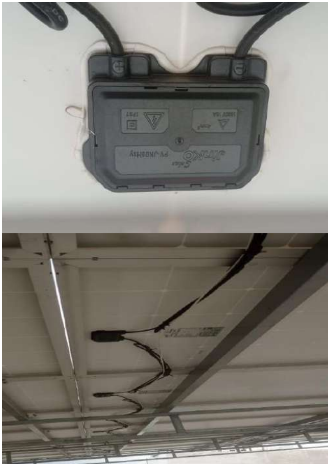
Figura 10. Instalación de los paneles: a) Caja de conexión y b) Conexión en serie. Fuente: elaboración propia.
